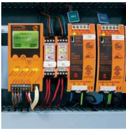
Les composants de tête du réseau AS-i montés en coffret.
