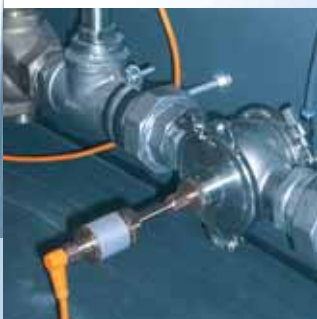
Le transmetteur de température TAA surveille la température du système lors de la pasteurisation.
