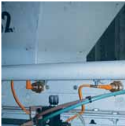
Des détecteurs inductifs détectent de manière fiable la position de vannes dans un silo de farine.
