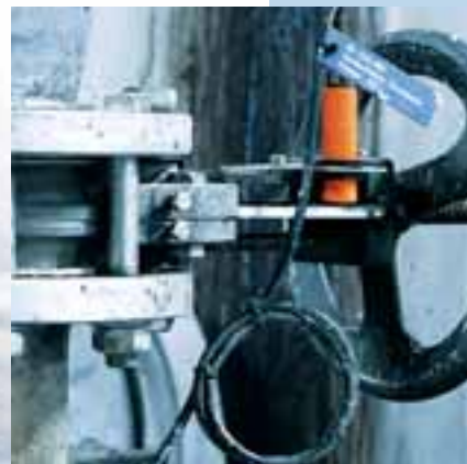
Le détecteur inductif détecte la position d'un robinet d'isolement dans une papeterie.
