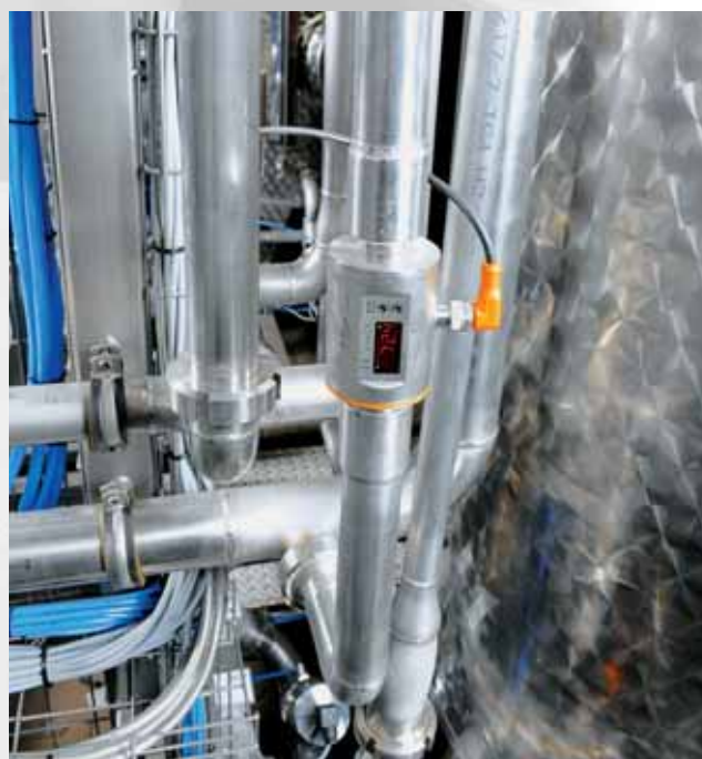
Capteur de débit électromagnétique dans le circuit d'eau pour le contrôle de quantités.
