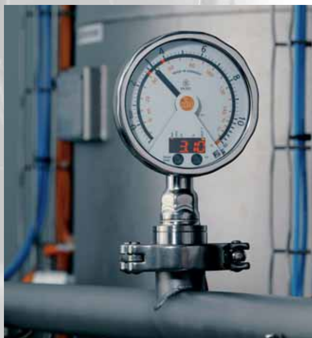
Contrôle de pression en ligne.
