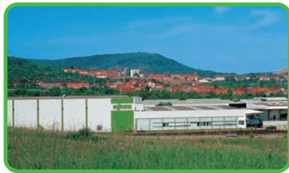
Sondershausen/Allemagne Site de production, centre logistique
