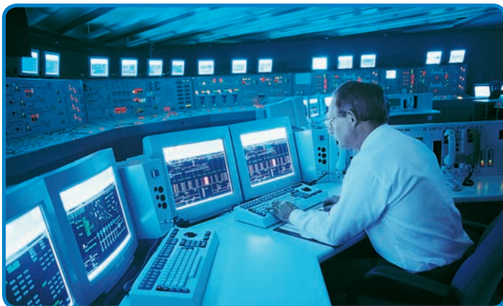
Salle de contrôle/Système de gestion
